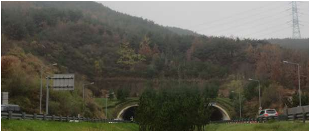
(시점부 절토사면 전경)
